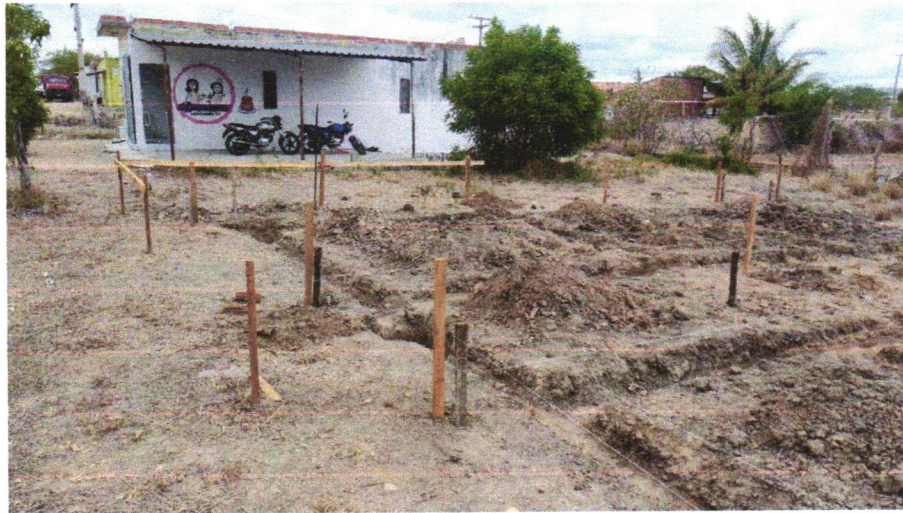
FOTO 05 – ESCAVAÇÃO MANUAL DE VALA PARA VIGA BALDRAME (INCLUINDO ESCAVAÇÃO PARA COLOCAÇÃO DE FÔRMAS). AF_06/2017
