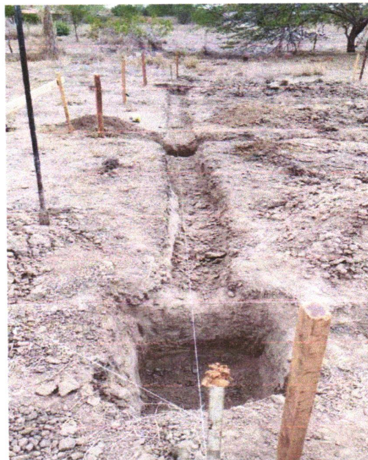
Foto 06 – ESCAVAÇÃO MANUAL DE VALA PARA VIGA BALDRAME (INCLUINDO ESCAVAÇÃO PARA COLOCAÇÃO DE FÔRMAS). AF_06/2017
