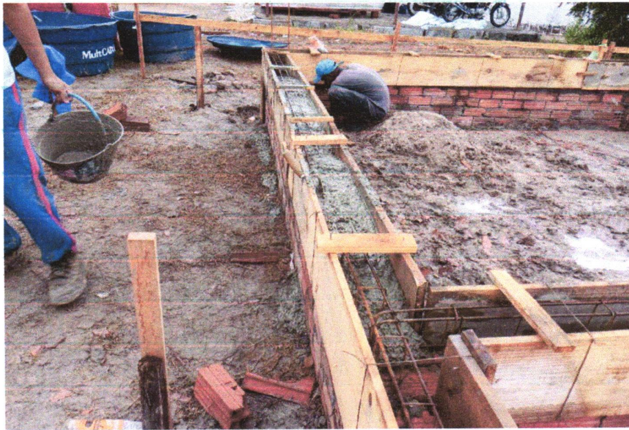
FOTO 11 - COMPOSIÇÃO REPRESENTATIVA) EXECUÇÃO DE ESTRUTURAS DE CONCRETO ARMADO, PARA EDIFICAÇÃO HABITACIONAL UNIFAMILIAR TÉRREA (CASA EM EMPREENDIMENTOS), FCK = 25 MPA. AF_01/2017
