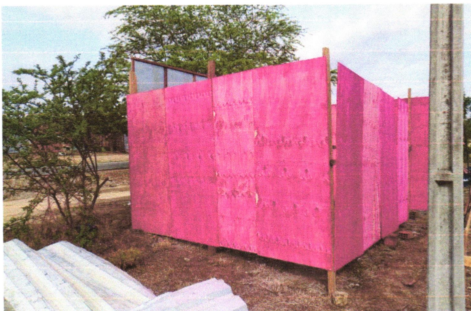
FOTO02 -Barracão para Obras de Médio Porte Reaproveitamento 2 vezes
