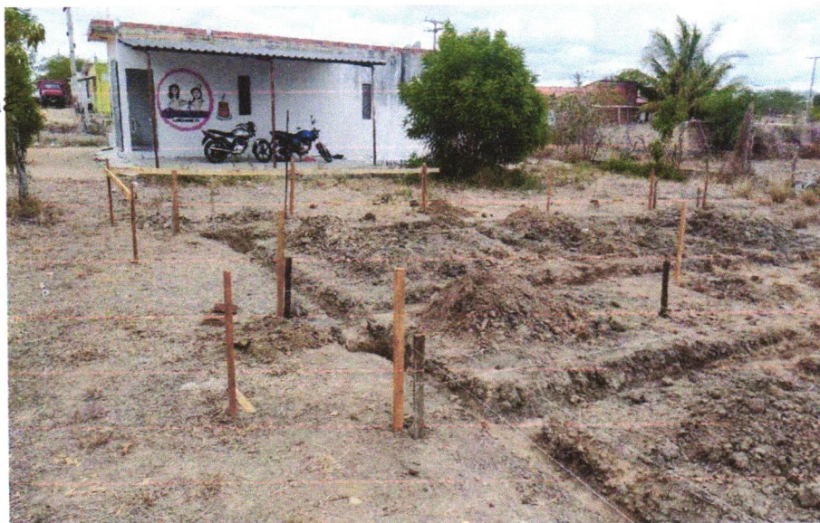
FOTO 04 - ESCAVAÇÃO MANUAL DE VALA PARA VIGA BALDRAME (INCLUINDO ESCAVAÇÃO PARA COLOCAÇÃO DE FÔRMAS). AF_06/2017
