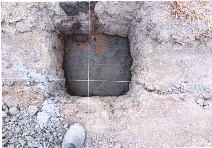
FOTO 08 - LASTRO DE CONCRETO MAGRO, APLICADO EM BLOCOS DE COROAMENTO OU SAPATAS, ESPESSURA DE 3 CM
