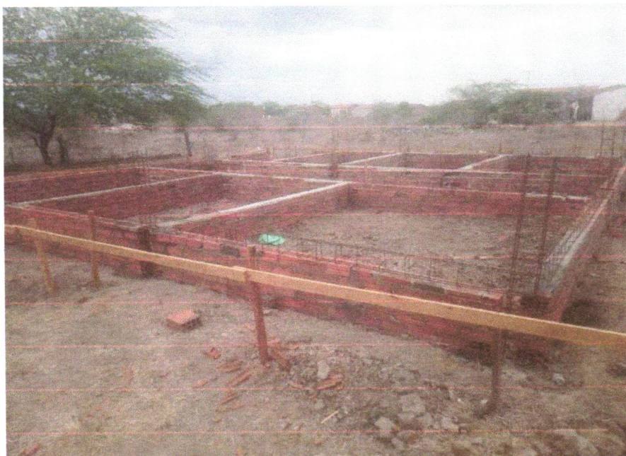
FOTO10 - COMPOSIÇÃO REPRESENTATIVA) EXECUÇÃO DE ESTRUTURAS DE CONCRETO ARMADO, PARA EDIFICAÇÃO HABITACIONAL UNIFAMILIAR TÉRREA (CASA EM EMPREENDIMENTOS), FCK = 25 MPA. AF_01/2017
